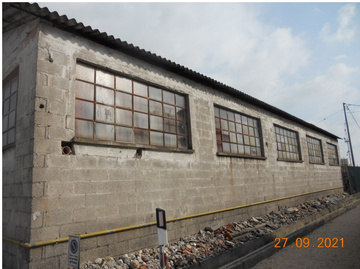
Foto 6: Vista prospetto ovest
