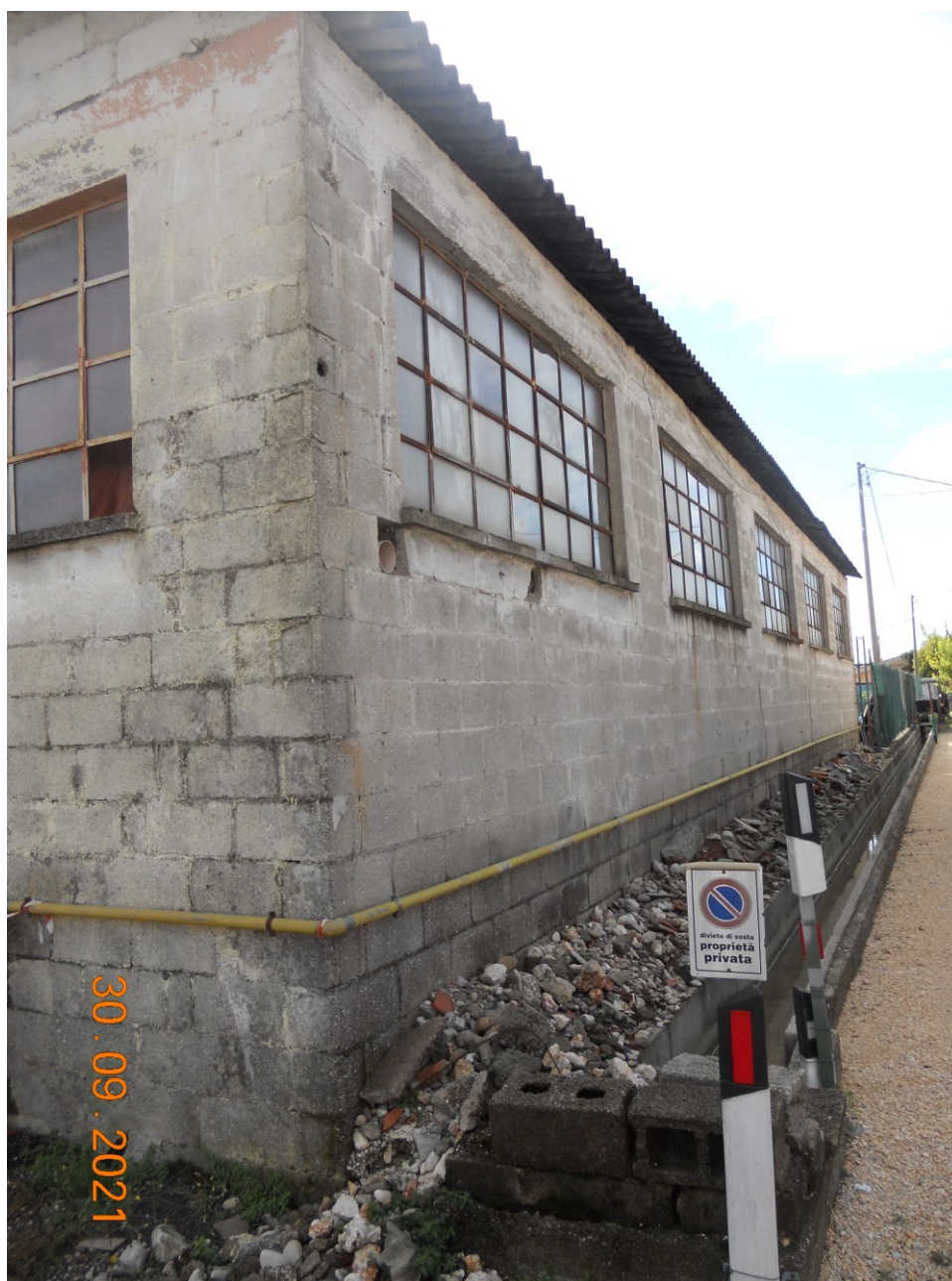
Foto 7: Particolare prospetto ovest
