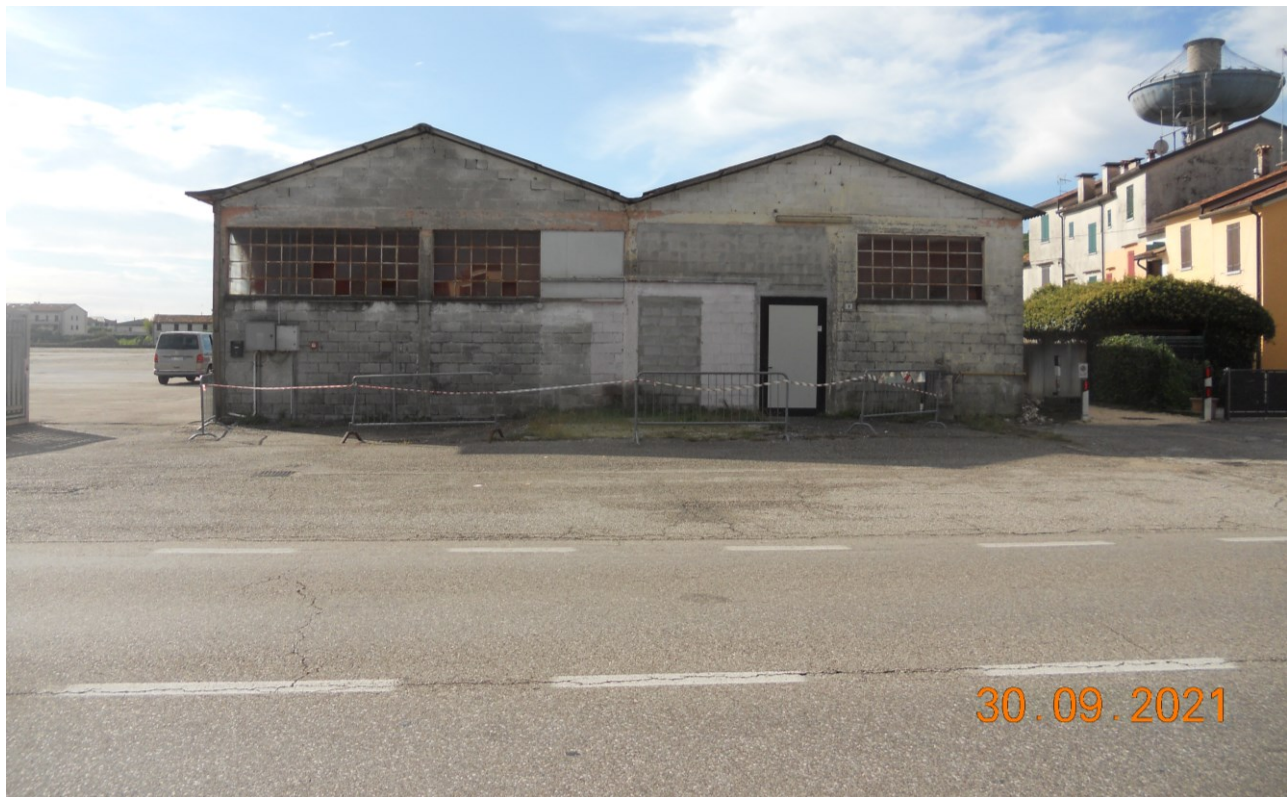
Foto 1: Vista prospetto nord
