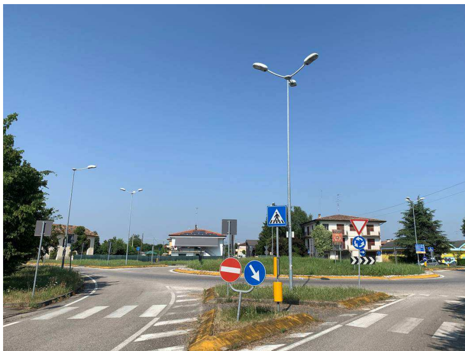
Situazione attuale Rotatoria Via Distrettuale – Via Zanco – Uscita Via Zanco
